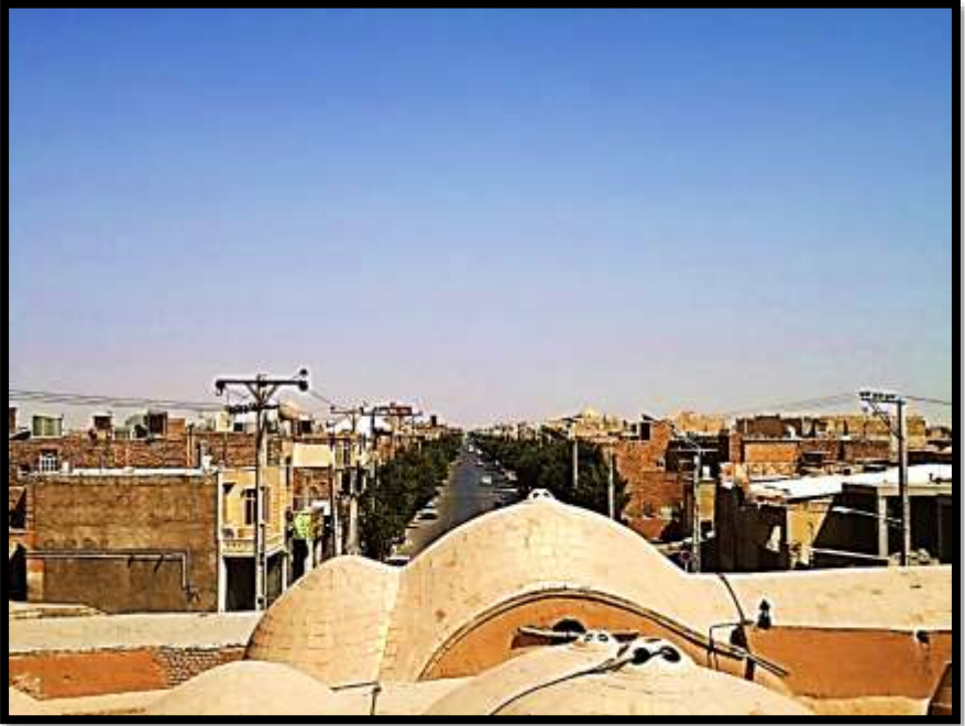
İki katlı evler ve kaldırım ađaçlaması
