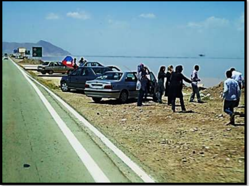
Gölün kıyıya yakın yerlerinde dolgu ile yol yapılmış
