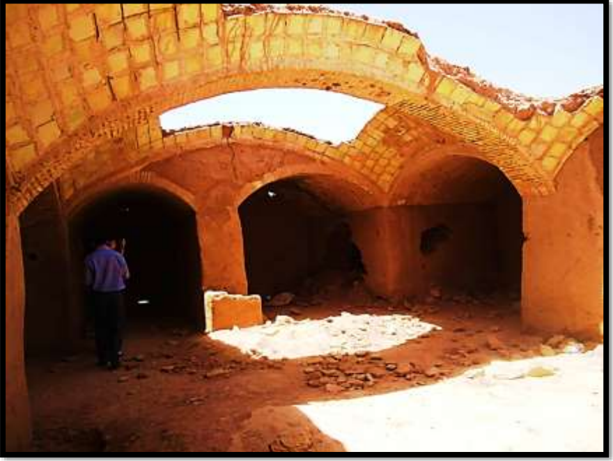
Terk edilmiş bir yapı
